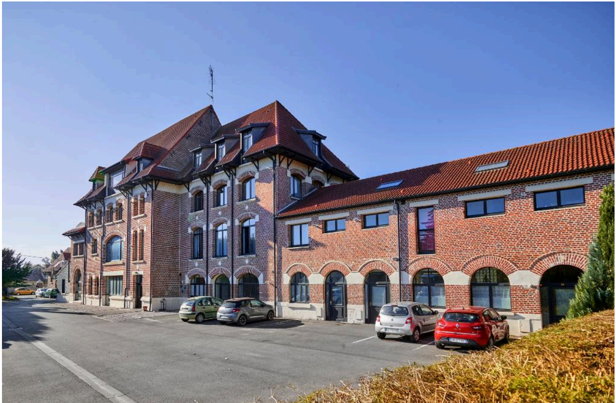
Façade sur cour de l'ancienne brasserie vue depuis le fond de la cour.
