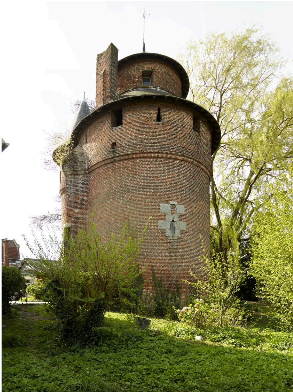
Vue générale de la tour prise depuis le nord-est.
