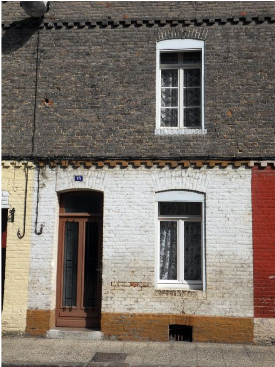
Détail de la façade d'un logement construit en 1864.
