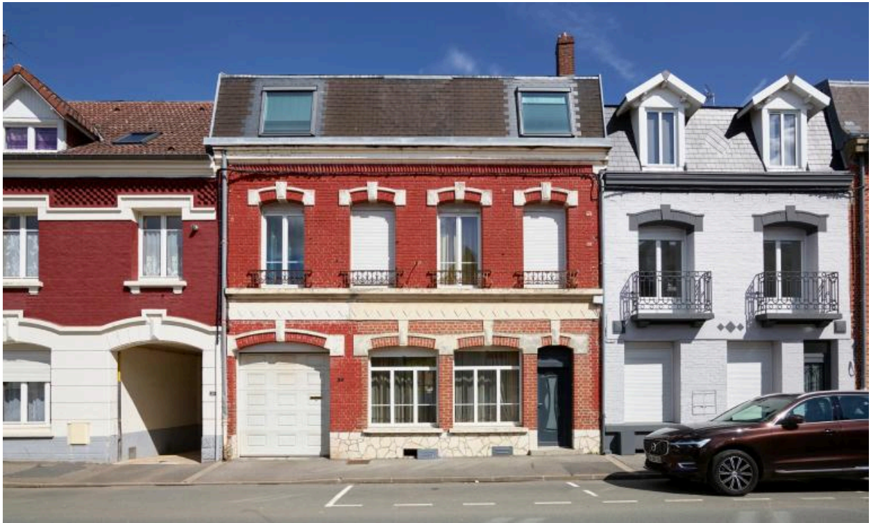
Maison, n° 30 rue du faubourg de Péronne. Vue de la façade principale. Exemple de maison avec distribution latérale et deux baies géminées en rez-de-chaussée.
