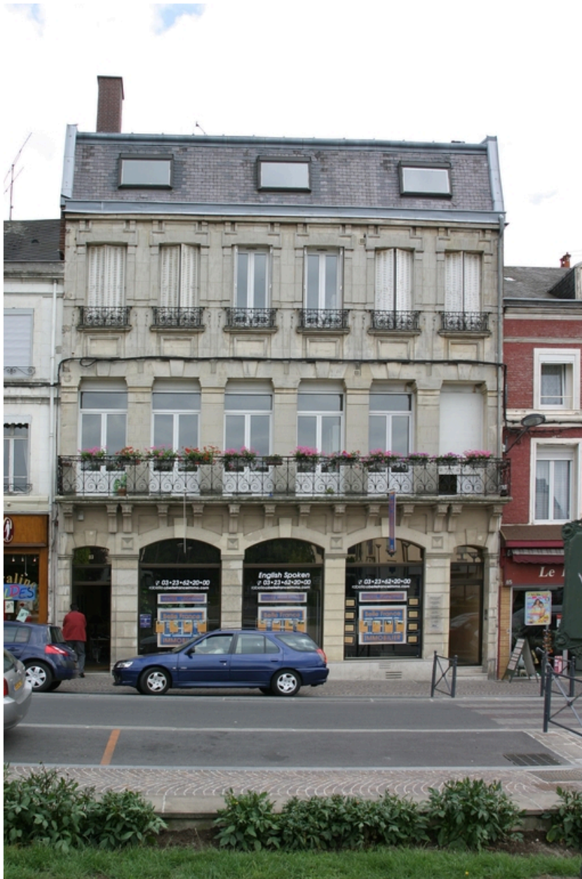
Façade antérieure, rue Emile-Zola.
