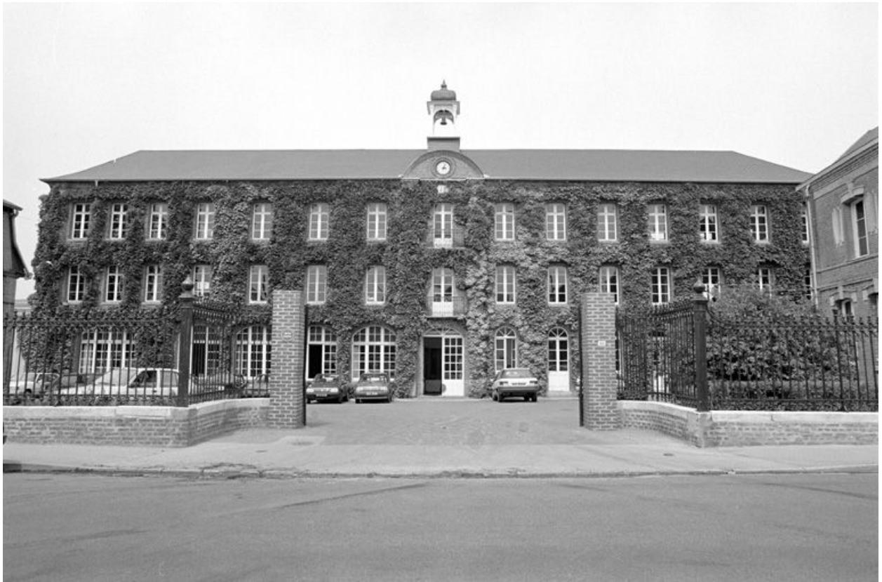
Atelier de fabrication principal, élévation antérieure, en 1990.
