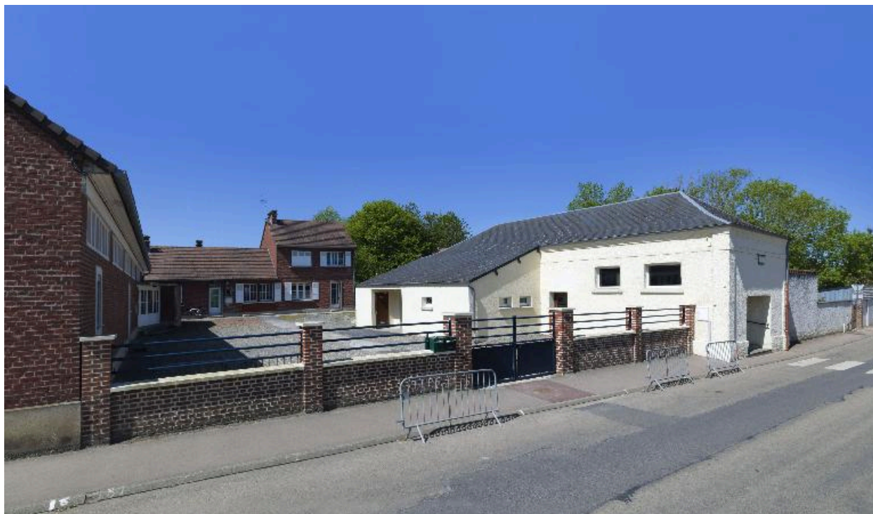
Cour et ancien logement des instituteurs.
