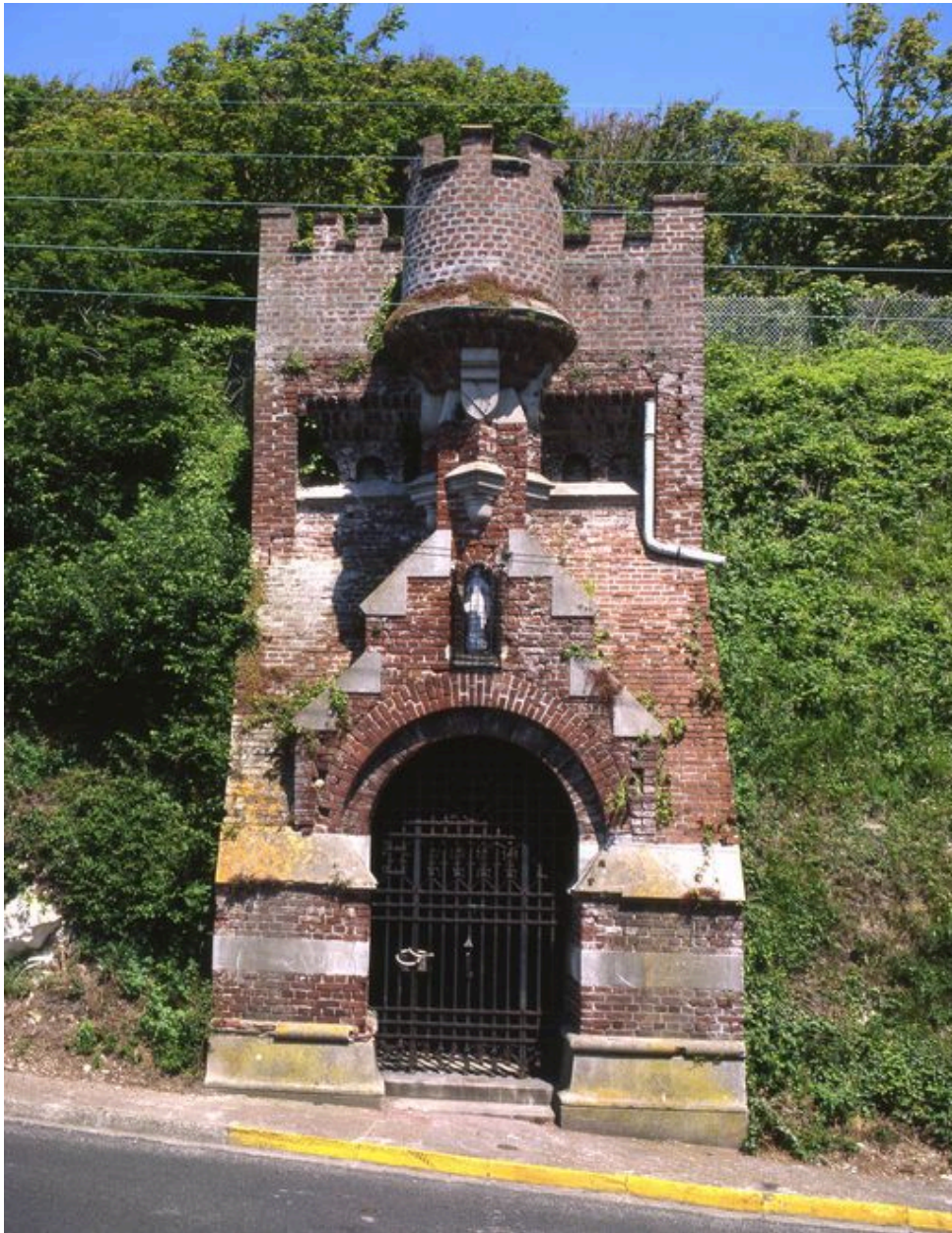
Vue d'ensemble de la porte élevée rue Saint-Pierre.
