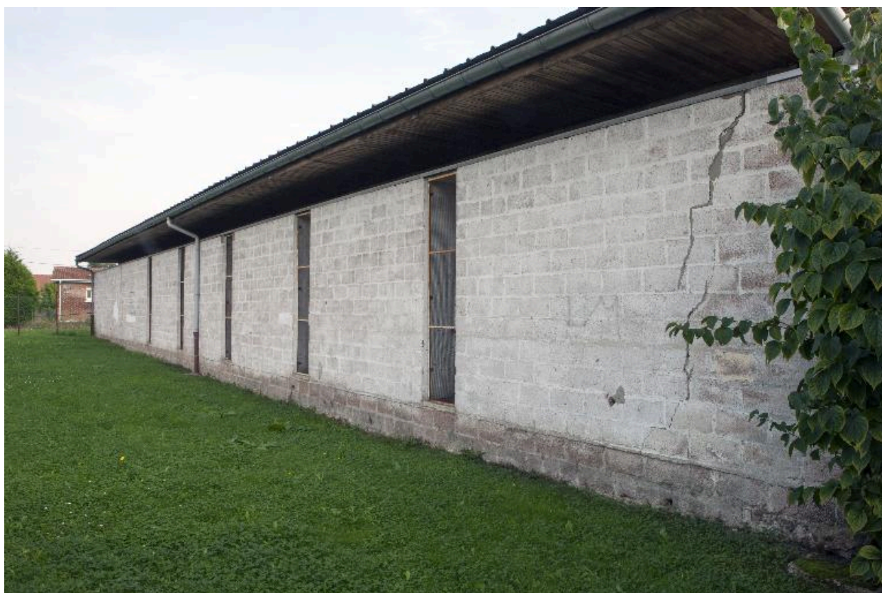
Élévation du flanc gauche de la chapelle.
