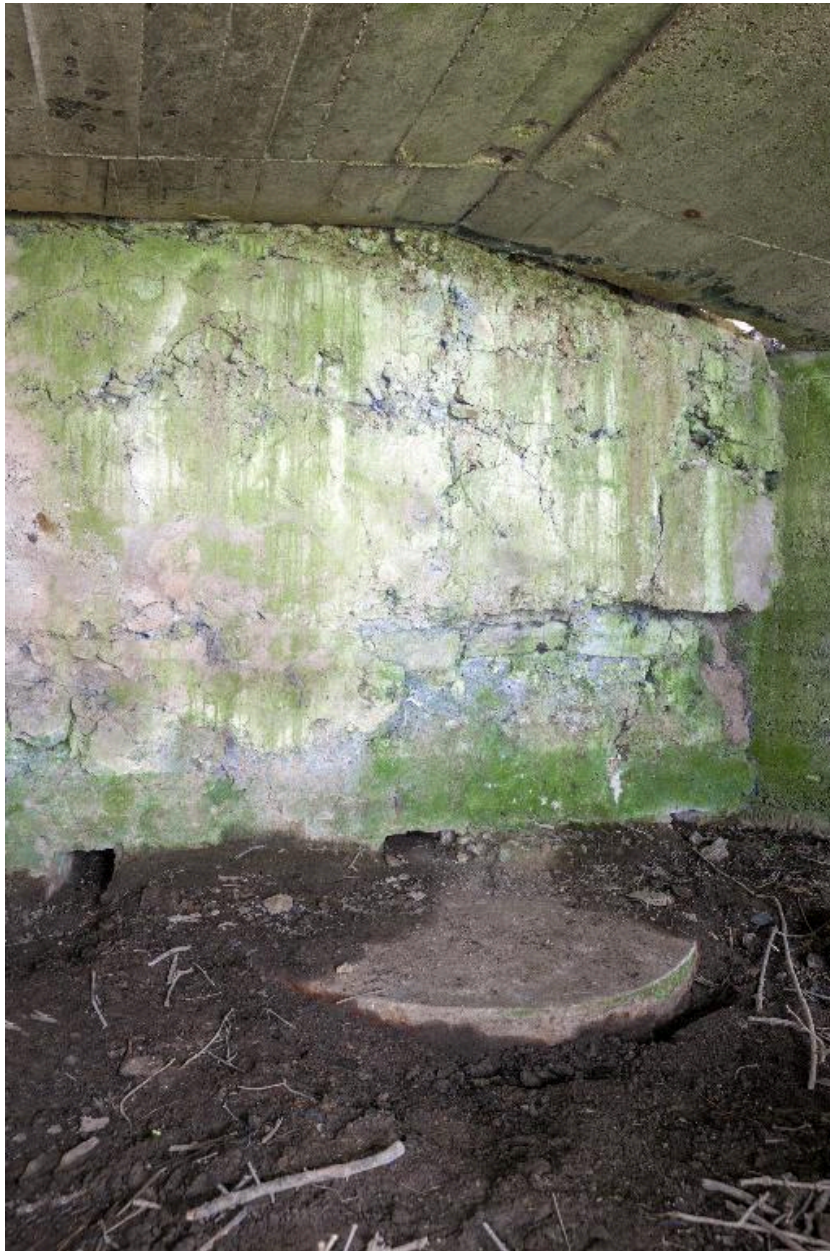
Chambre de tir, ouverture de tir condamnée
