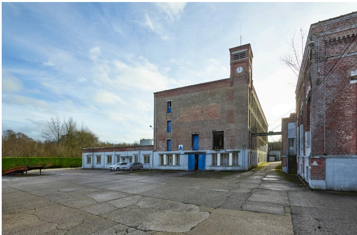
Bâtiment A, vue d'ensemble nord.
