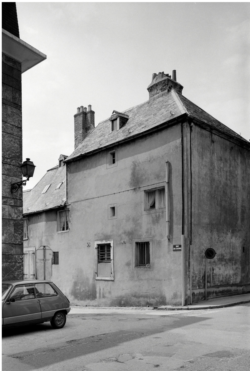
Façade rue des Echevins.
