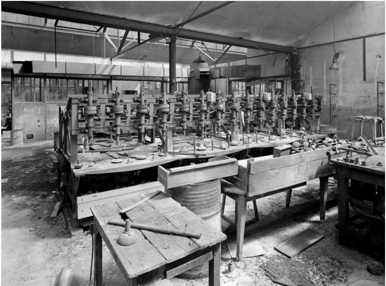
Atelier de fabrication reconstruit après la guerre : banc de polissage.
