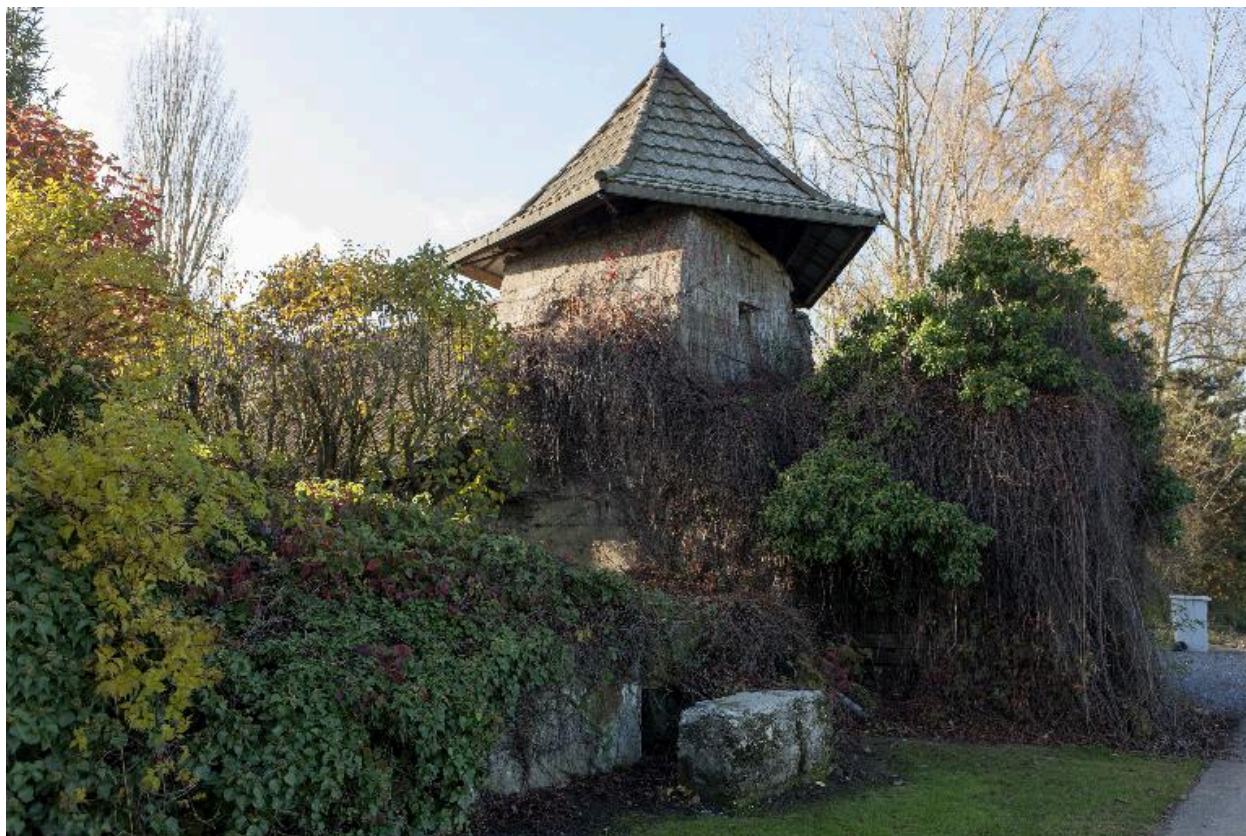
Vue générale, vers le nord-ouest
