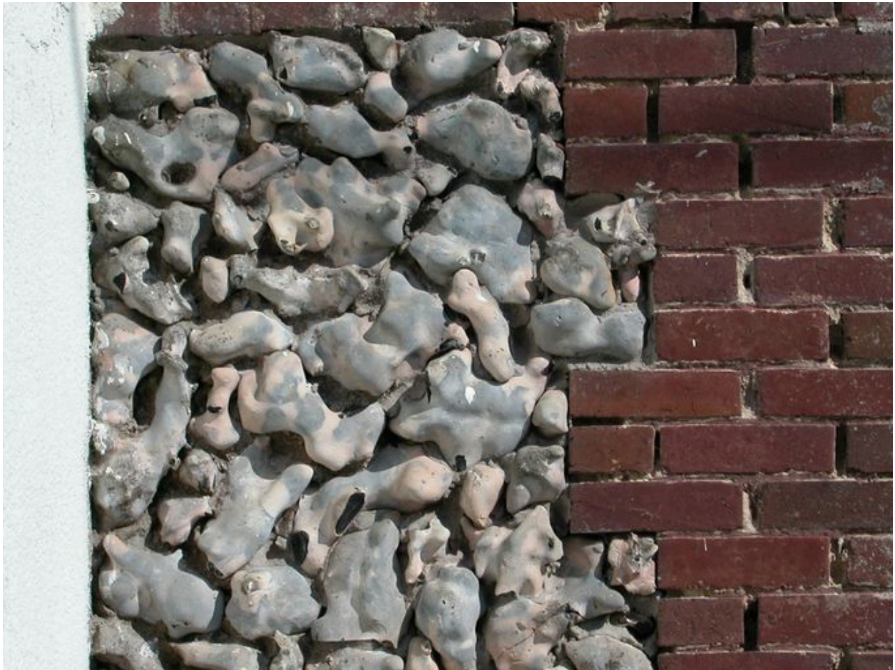
Détail du parement de silex du soubassement.
