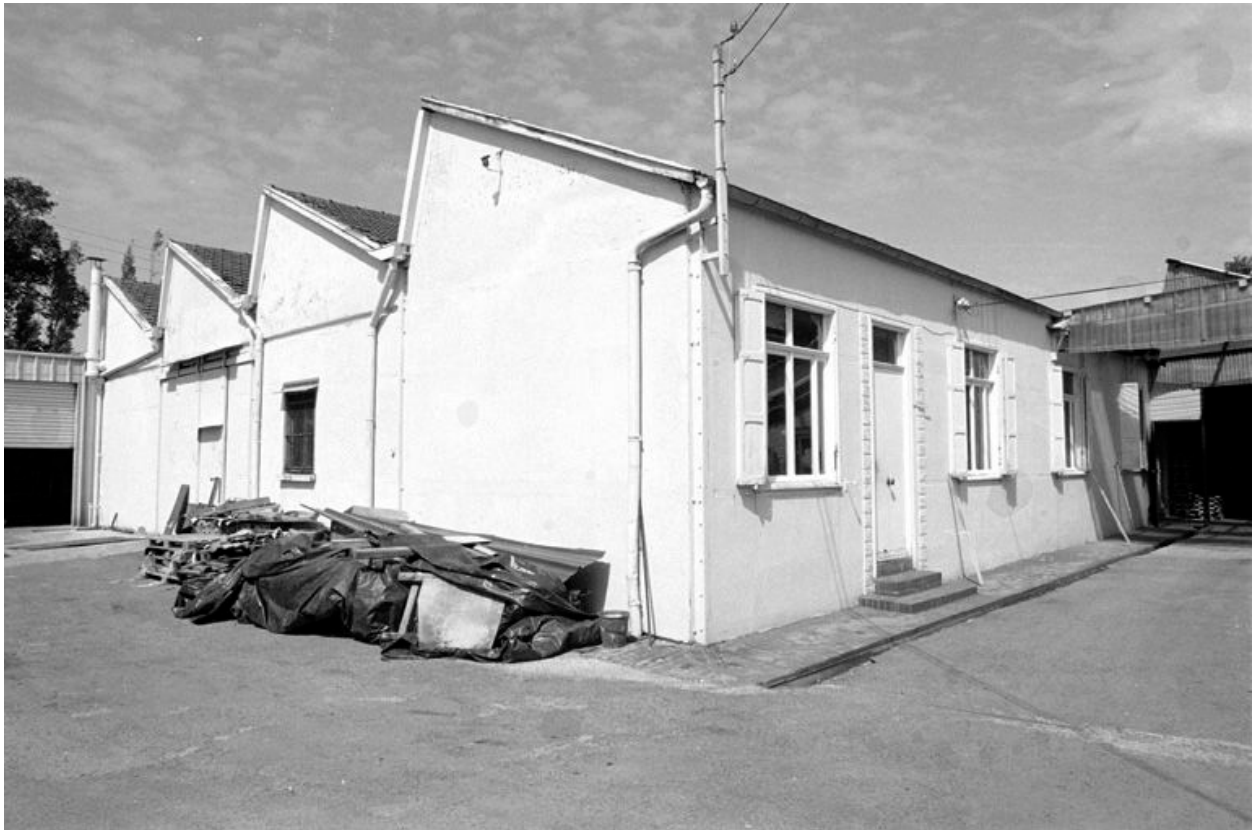
Atelier de fabrication, vue partielle, en 1990.
