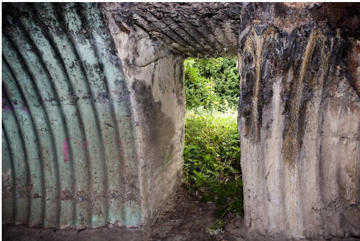
Entrée depuis l'intérieur
