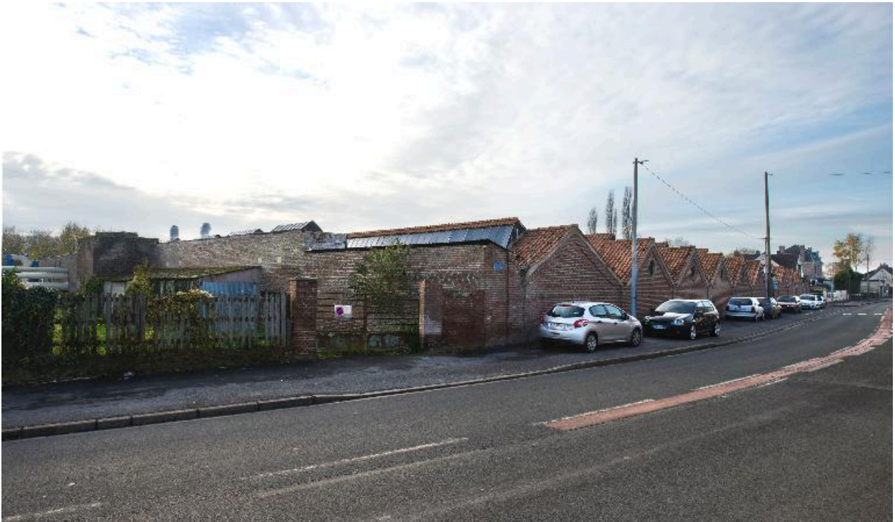
Façade sur rue de l'ancienne filature.
