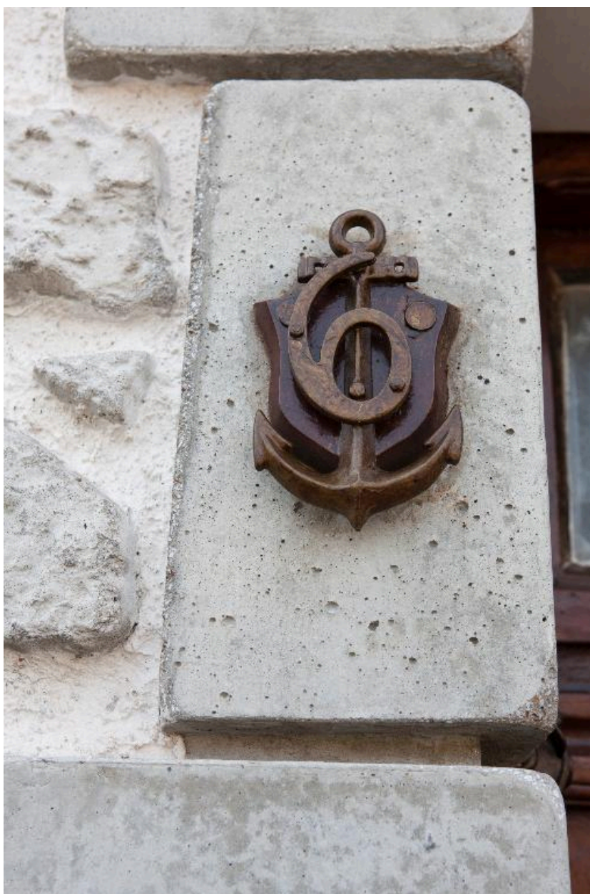
Maconnerie, détail d'un fer d'ancrage.
