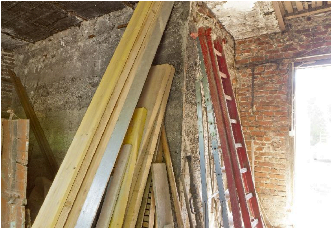
Mur extérieur de la casemate pris dans un corps de ferme
