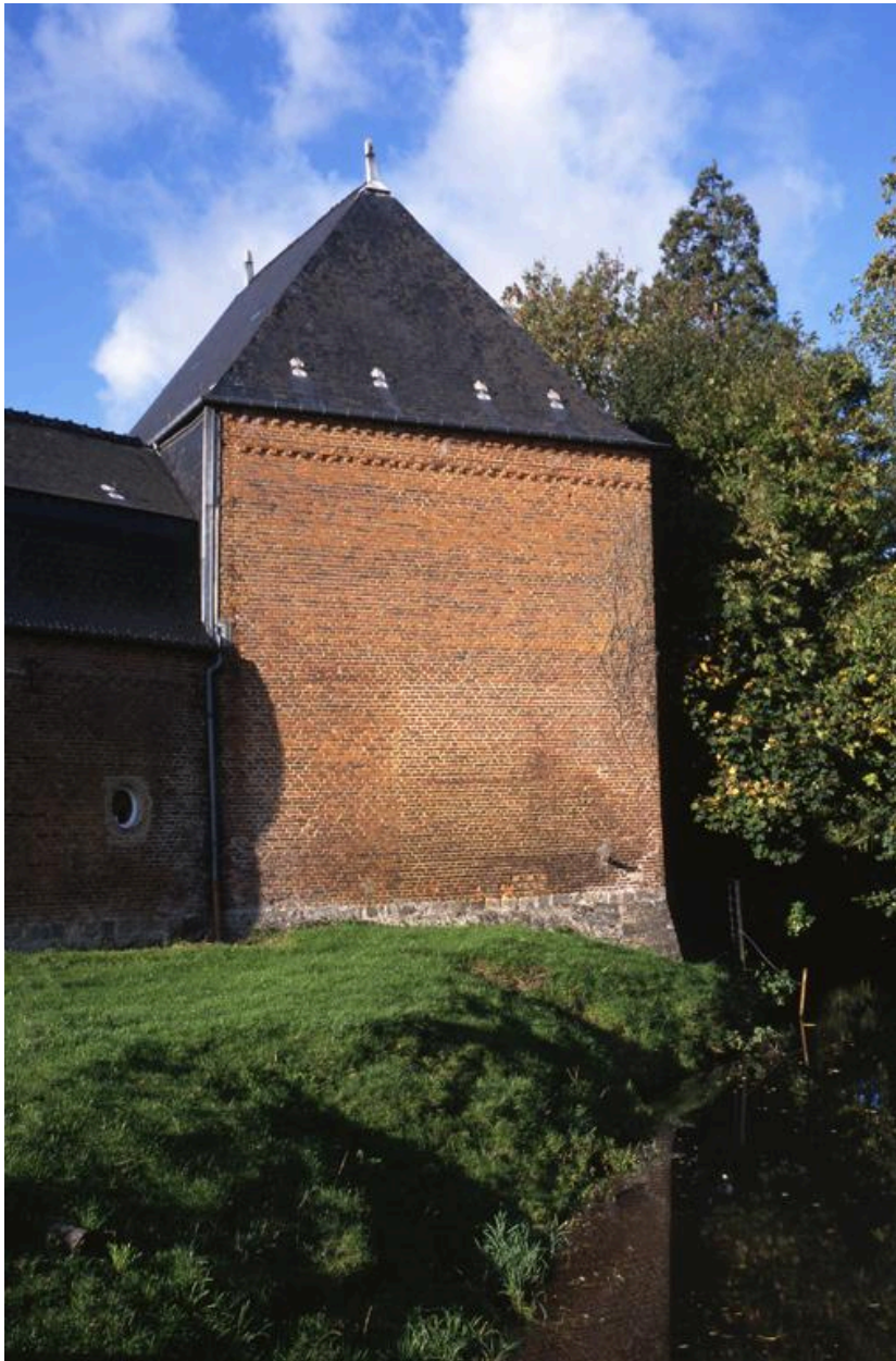
Le pavillon d'angle de la ferme.
