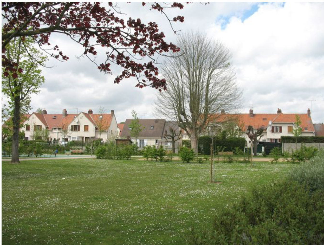
Anciens logements des contremaîtres intégrés dans la cité ouvrière de la Colorante.
