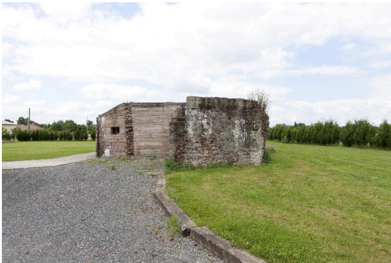
Pignon nord vers le sud-ouest
