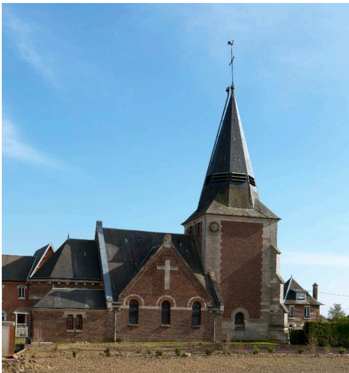
Vue générale depuis le nord.
