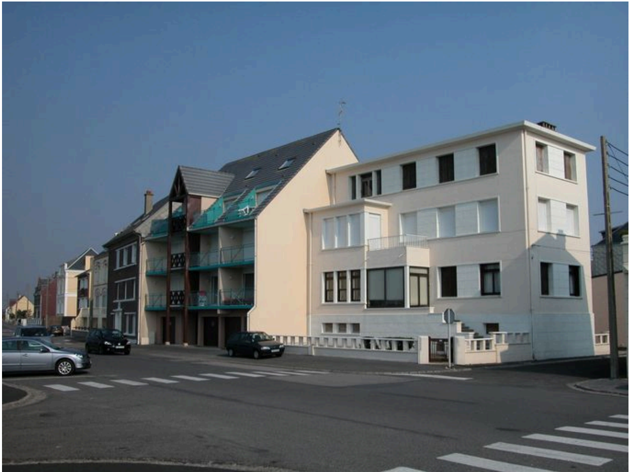
Constructions sur le front de mer.
