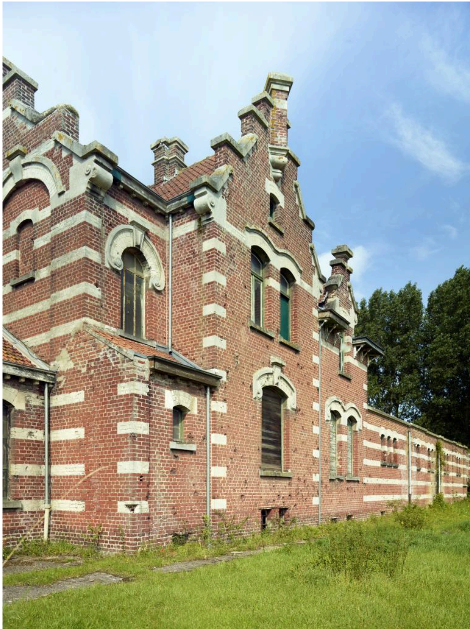
Logement du chef de cultures, vue partielle depuis l'est.
