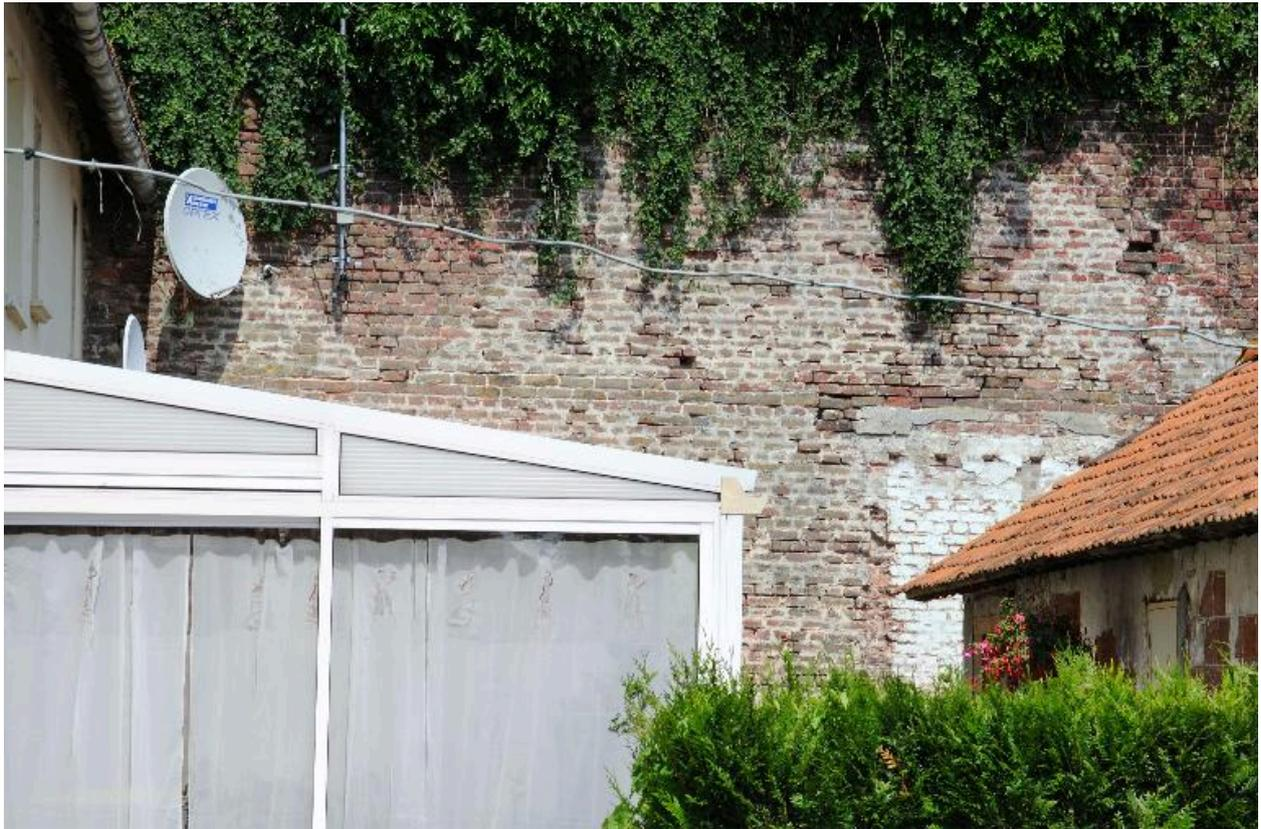
Traces d'un ancienne toiture en shed sur le mur en brique en fond de parcelle.
