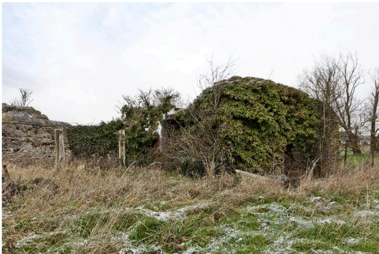
Casemate sud. Vue vers le nord.
