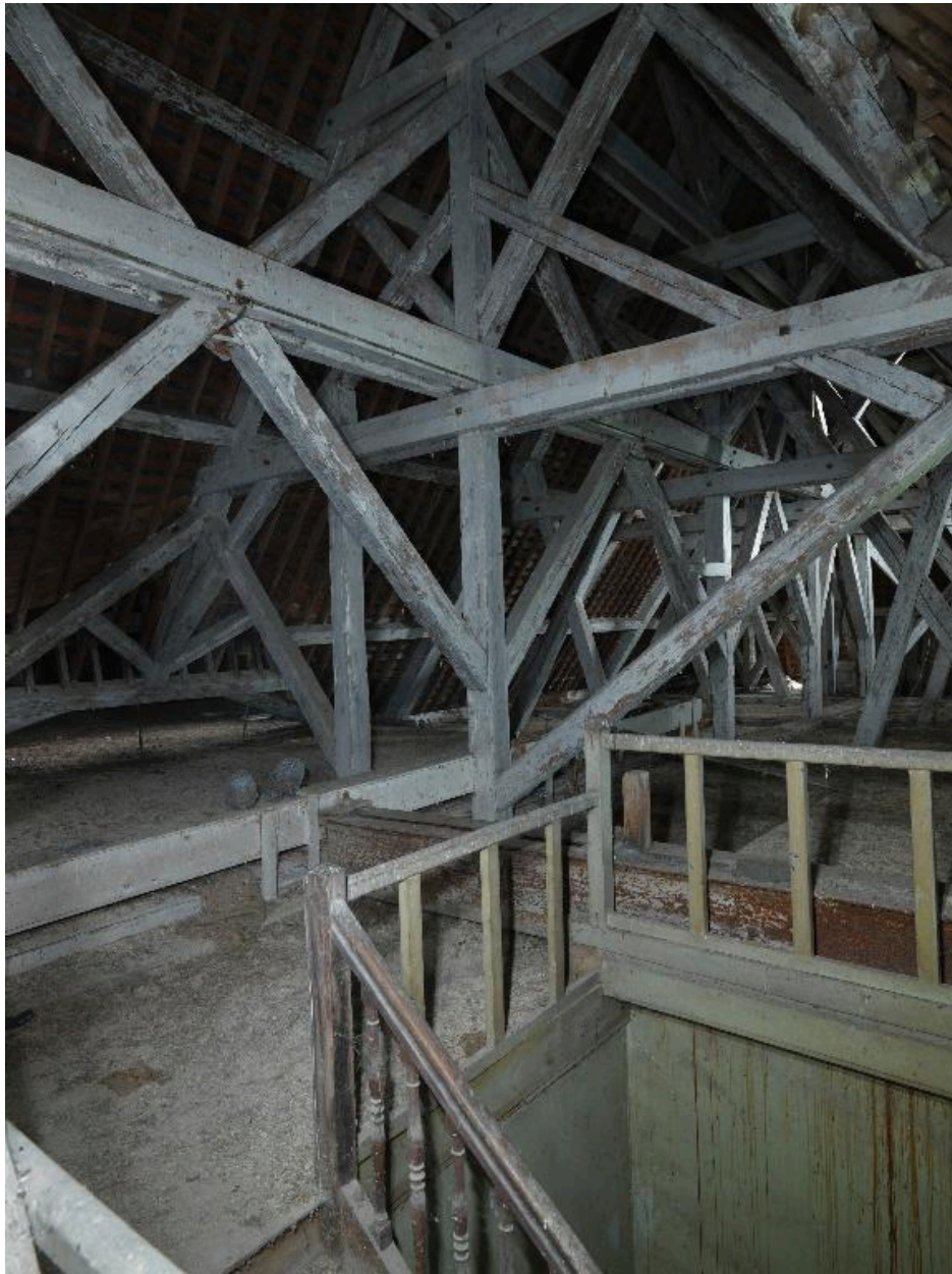
Détail de la partie centrale de la charpente des combles.
