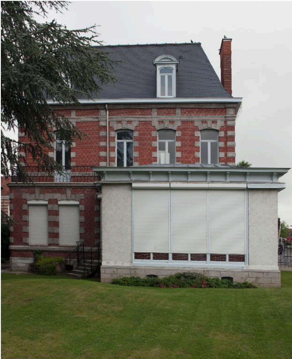
Vue générale de la façade postérieure.
