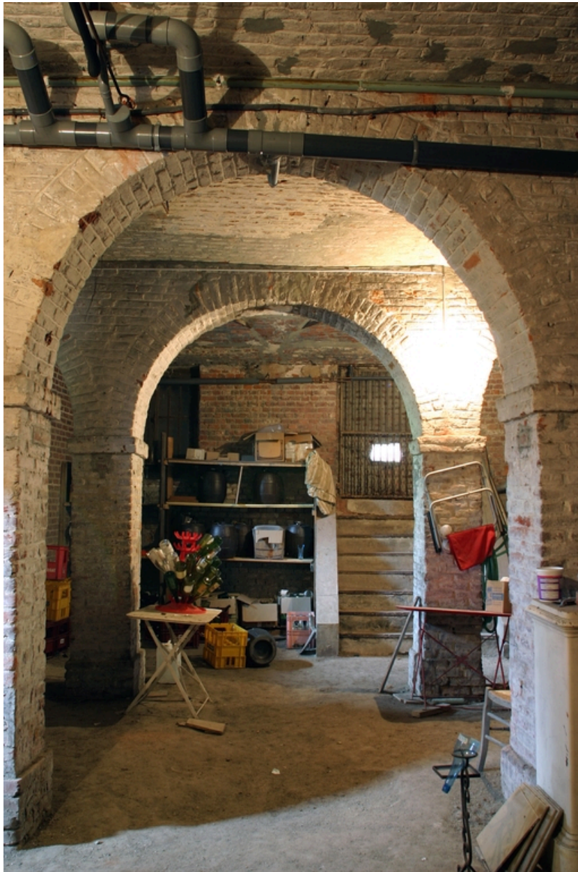
Vestiges du tissage, partie nord : sous-sol.
