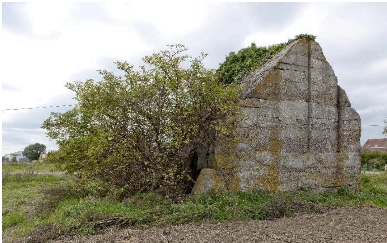
Vue vers le nord-ouest
