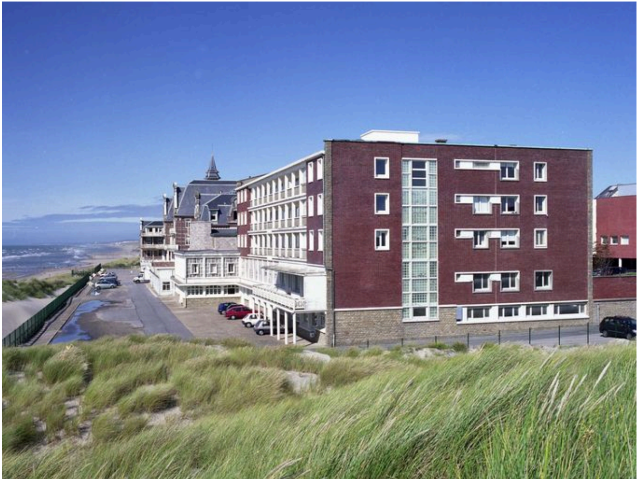
Elévation générale sur la plage, vue en enfilade prise depuis le sud.
