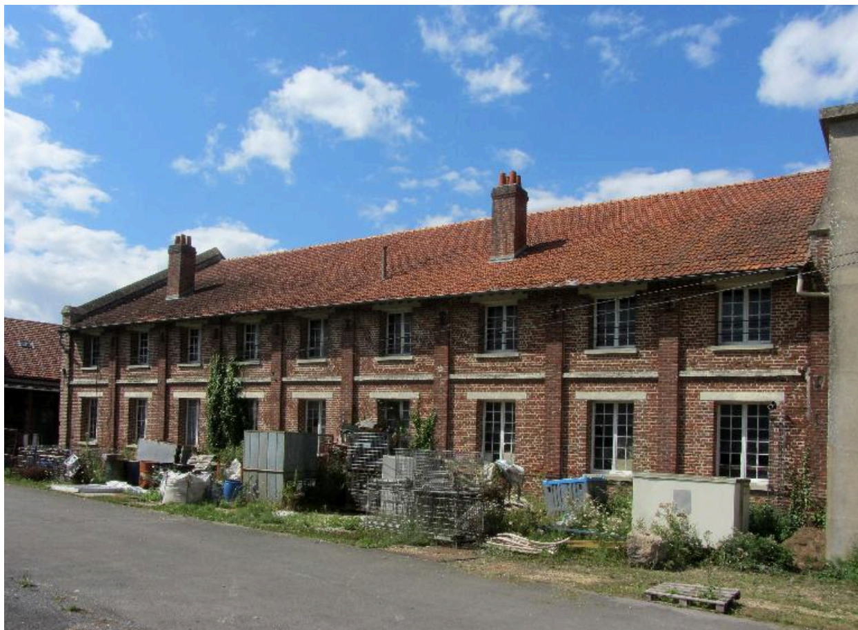
Vue de la façade sud-est des ateliers.
