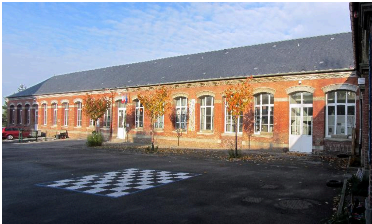
Façade sur cour des salles de classe.
