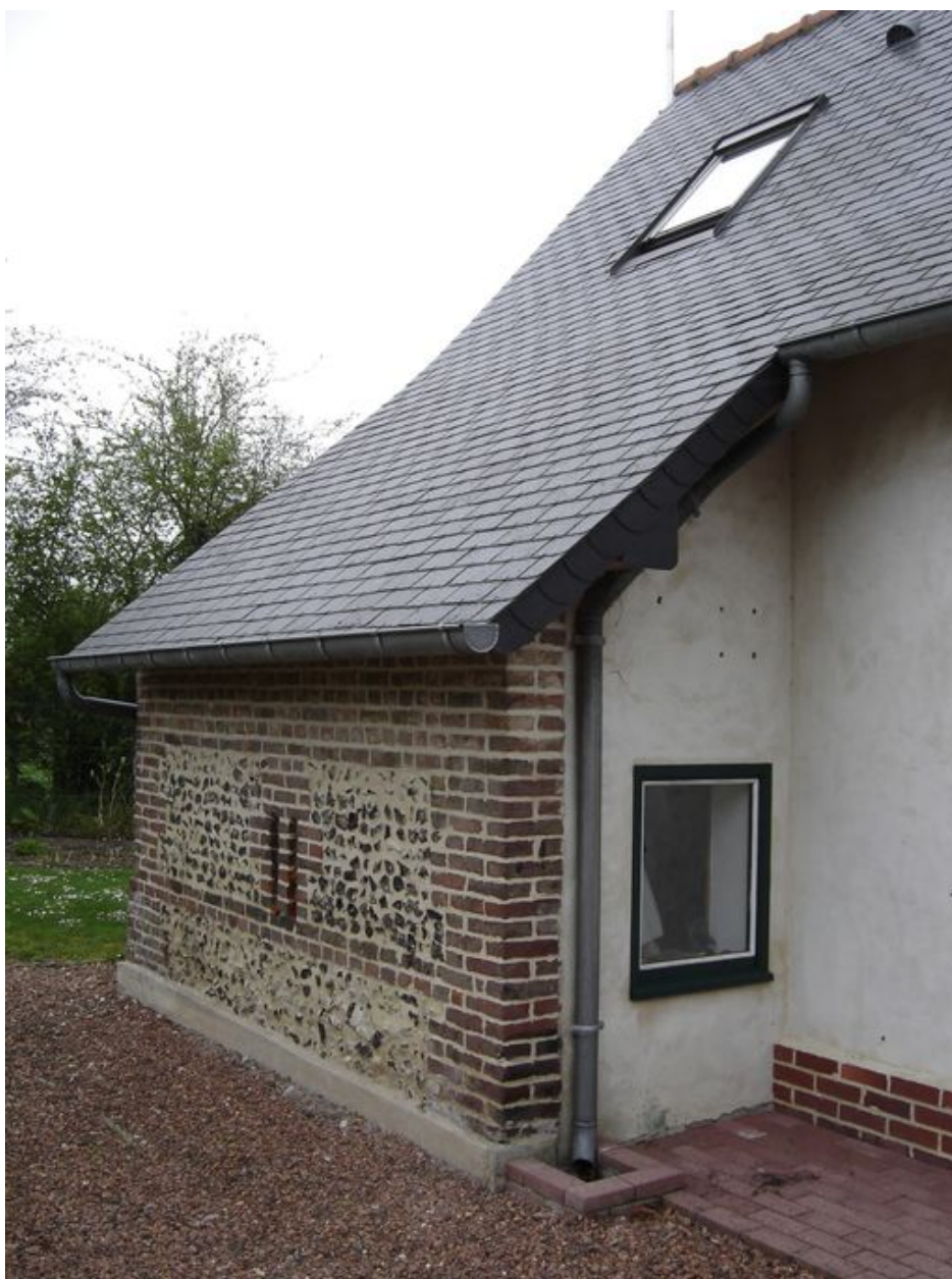
Vue de l'excroissance sur la face postérieure de la maison.
