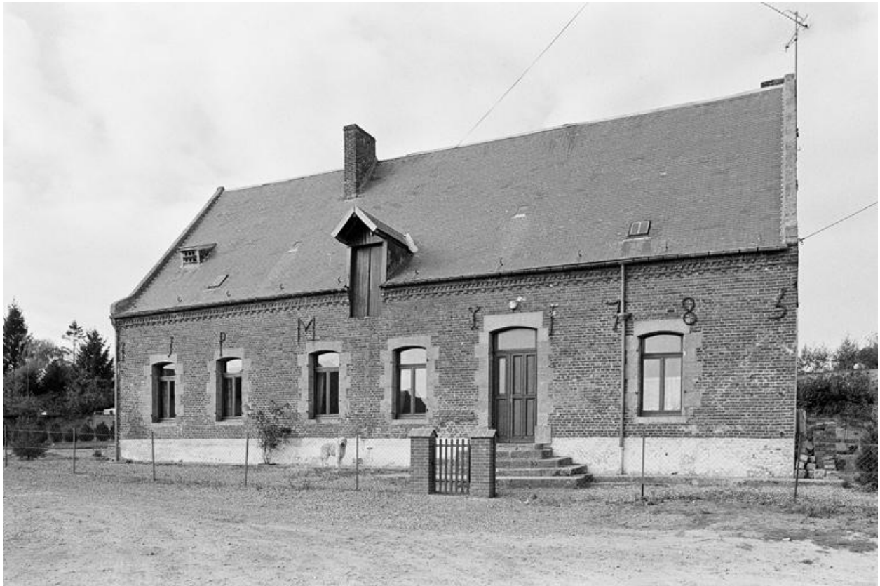
Vue de l'élévation sur cour de l'étable.
