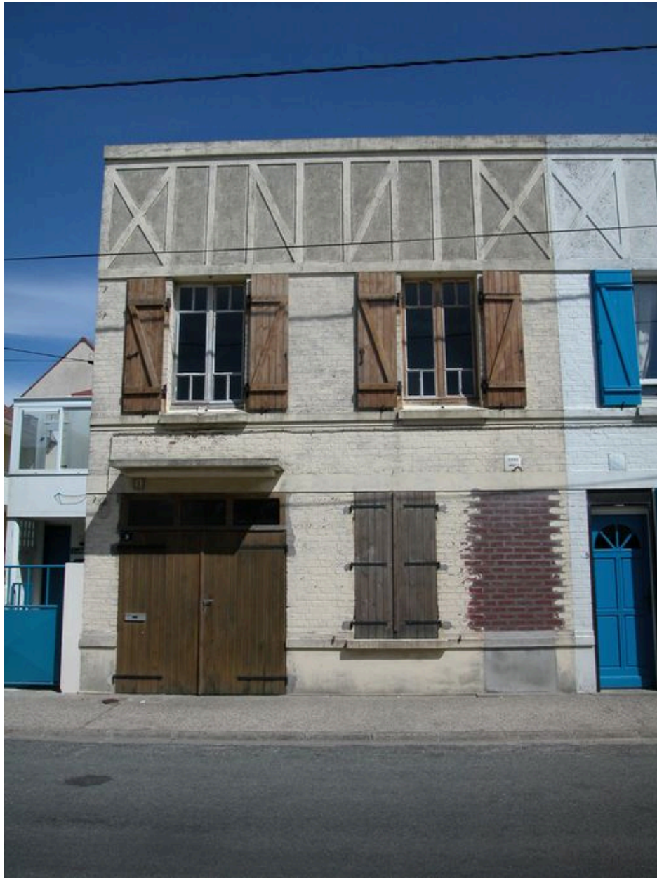
Logement dit Chez Nous (XA 190).
