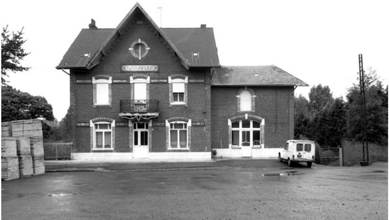
Vue d'ensemble de la façade.
