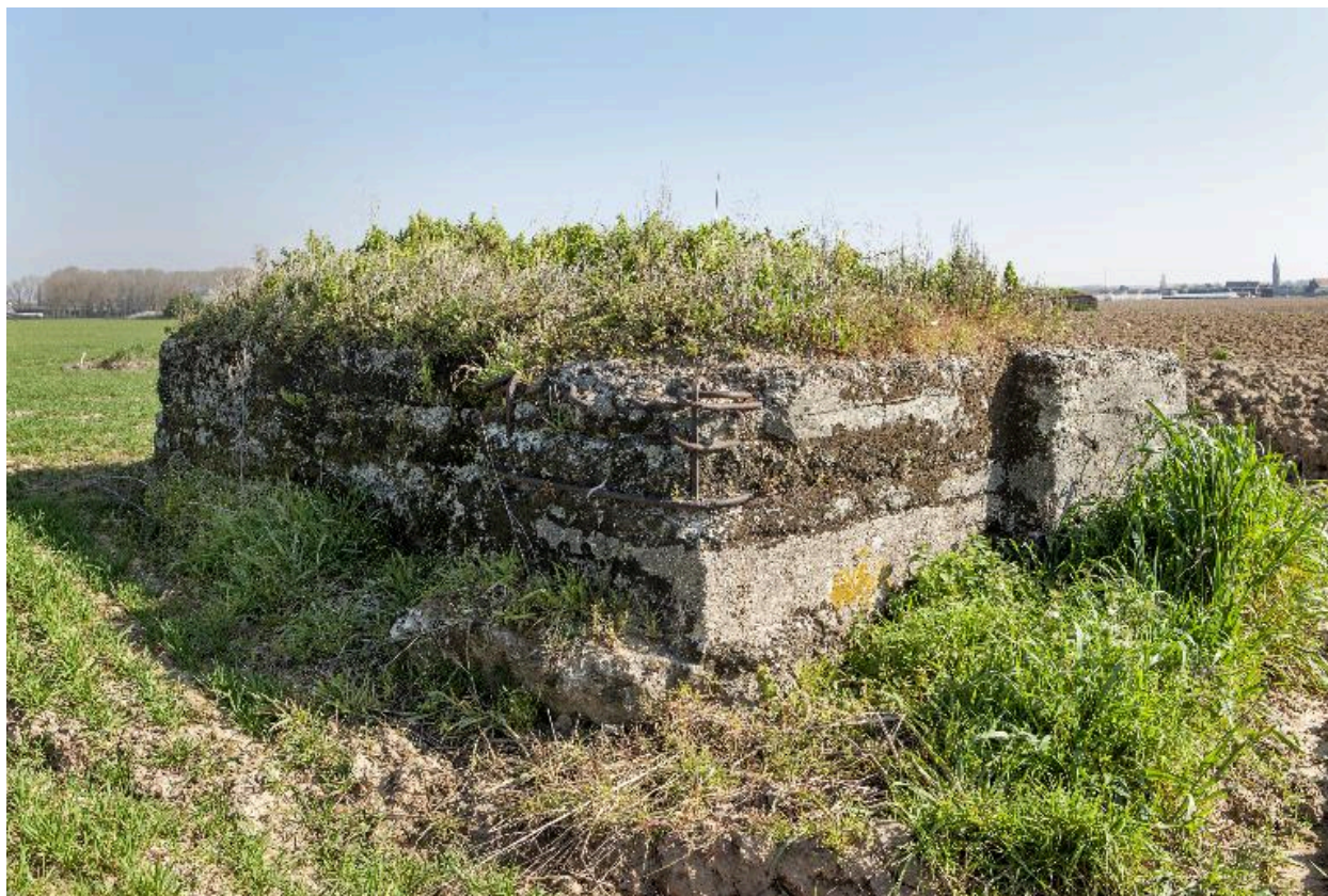
Vue de 3/a arrière, vers le nord-est
