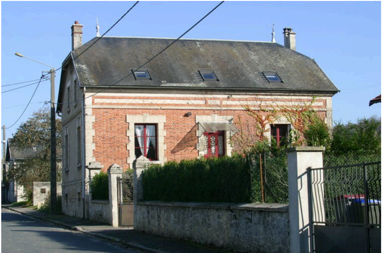
Vue générale de la façade principale.
