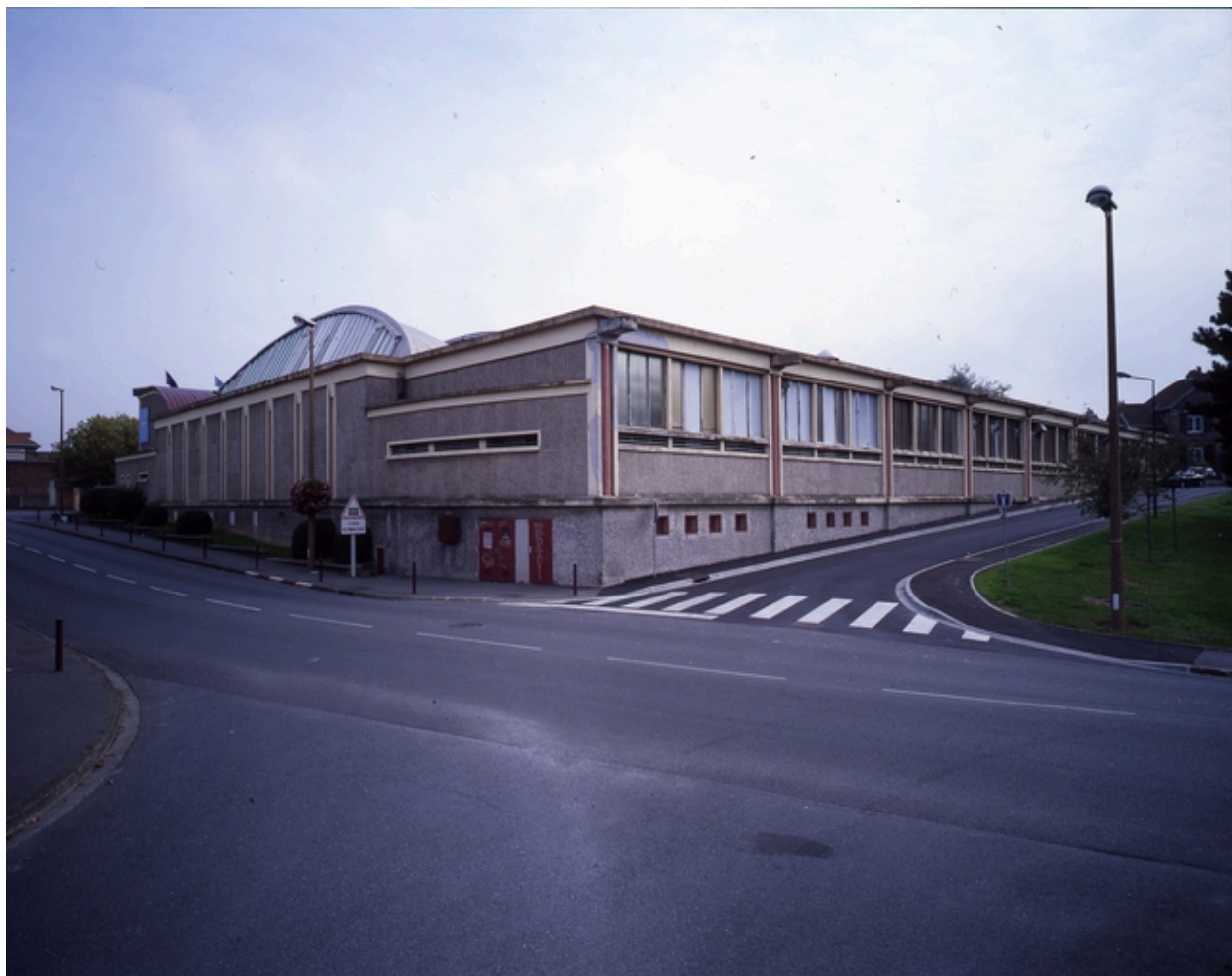
Façade de l'usine, rue Pierre-Semard.
