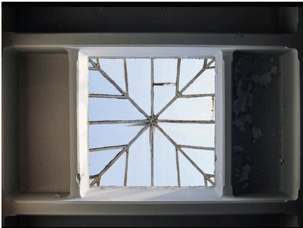
Vue intérieure des bureaux. Vue zénithale d'une verrière.
