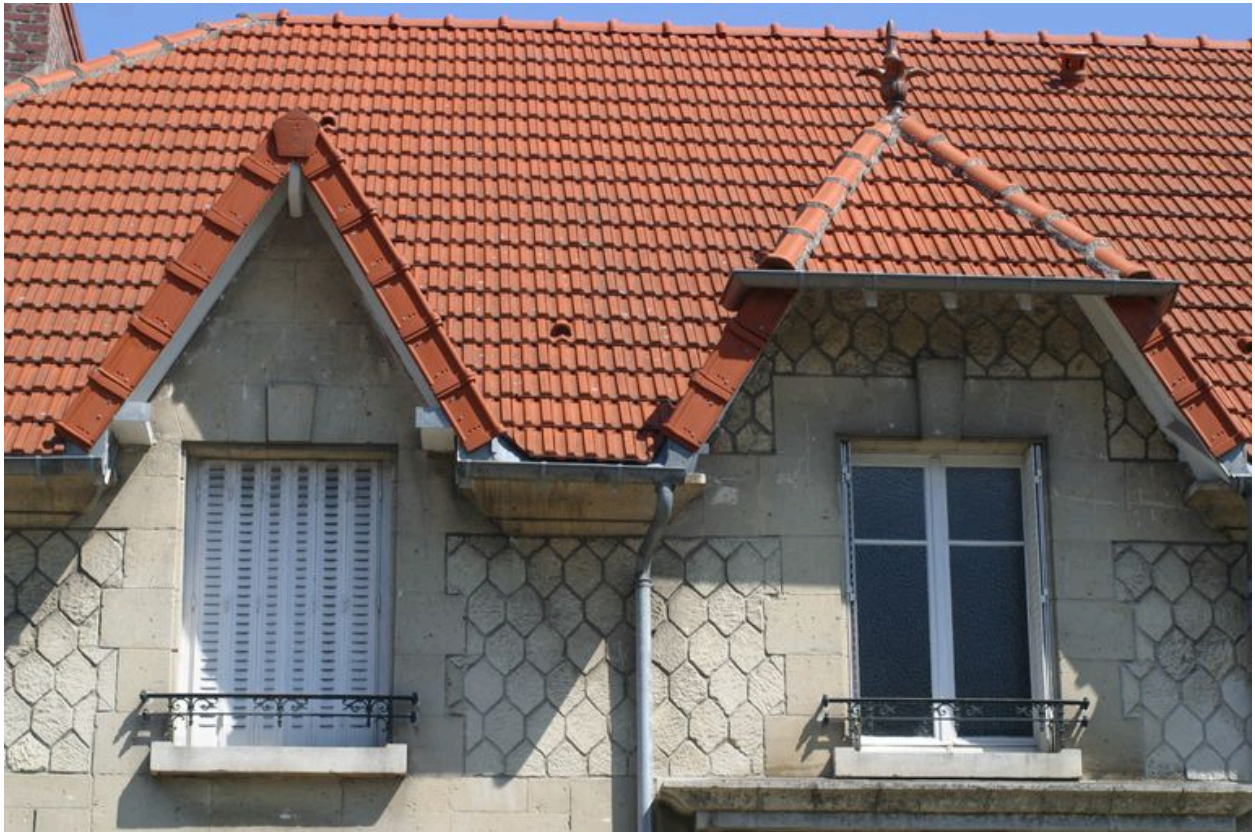
Détail des lucarnes.
