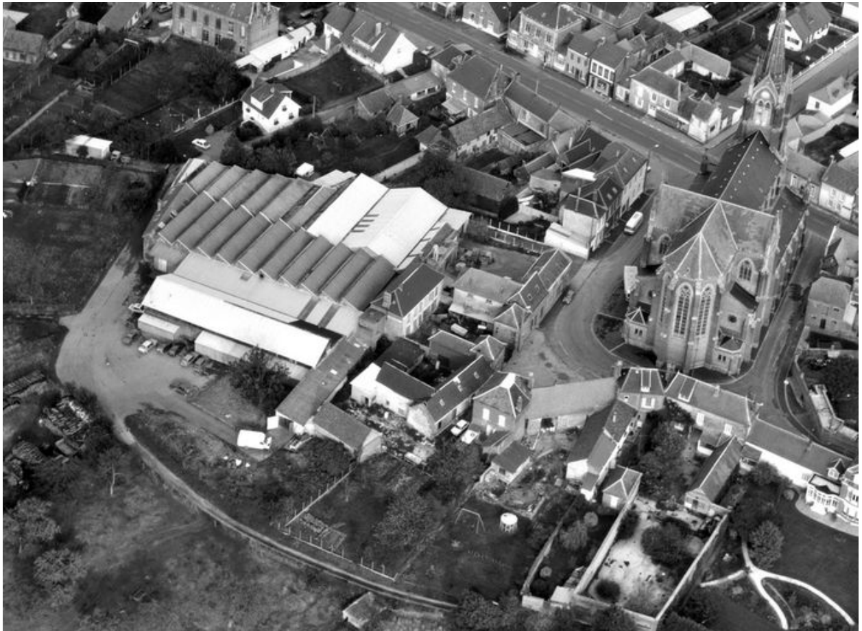
Vue aérienne, flanc ouest.
