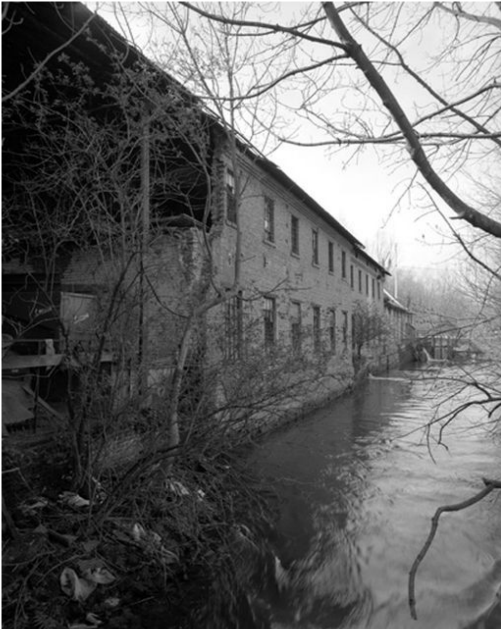
Vue de l'atelier (flanc nord).
