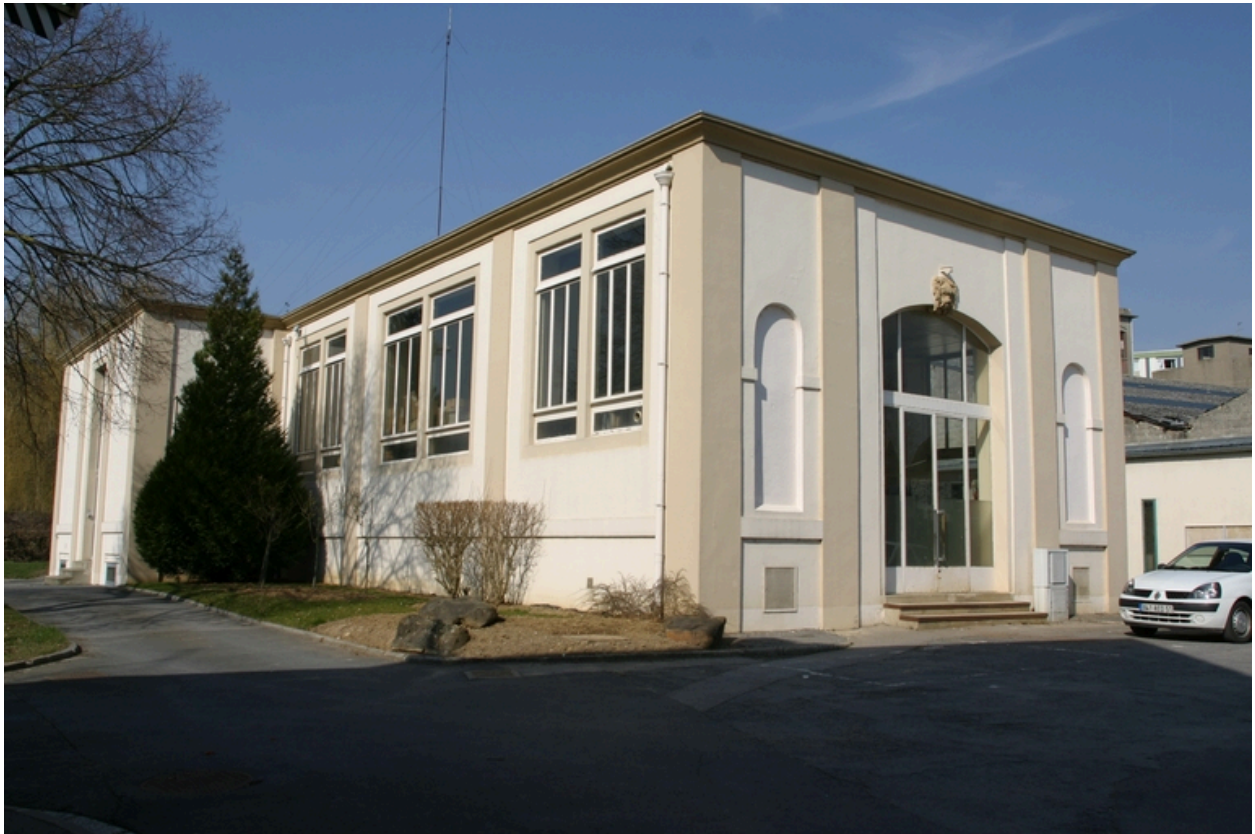
Anciennes salle des machines et chaufferie.
