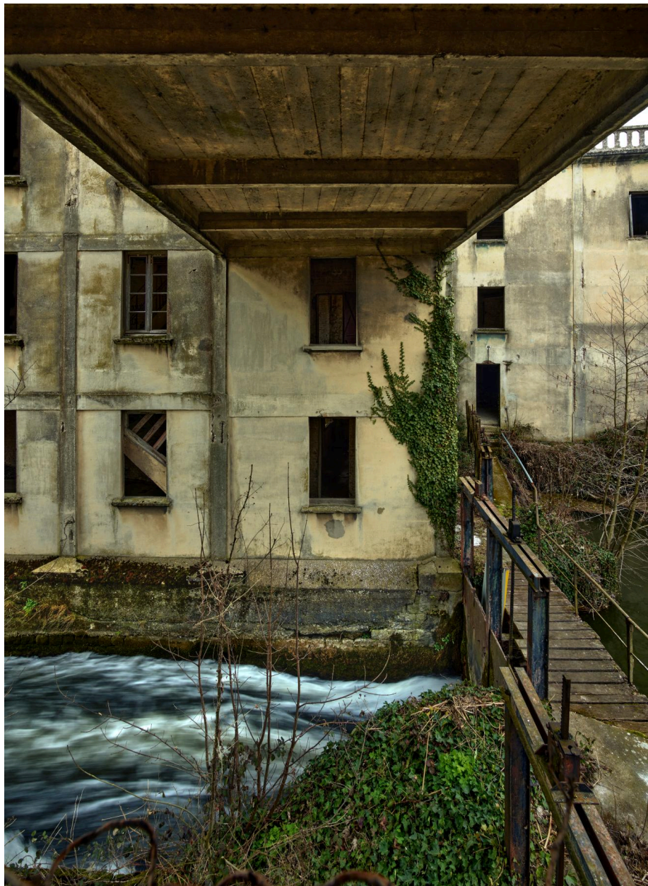
Détail de la coulerie et du tablier de la passerelle reliant les deux parties de la minoterie.
