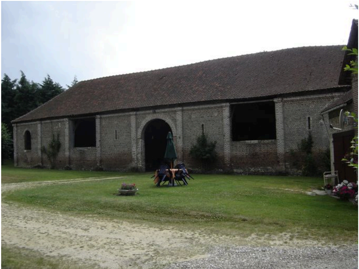
Vue de la grange.
