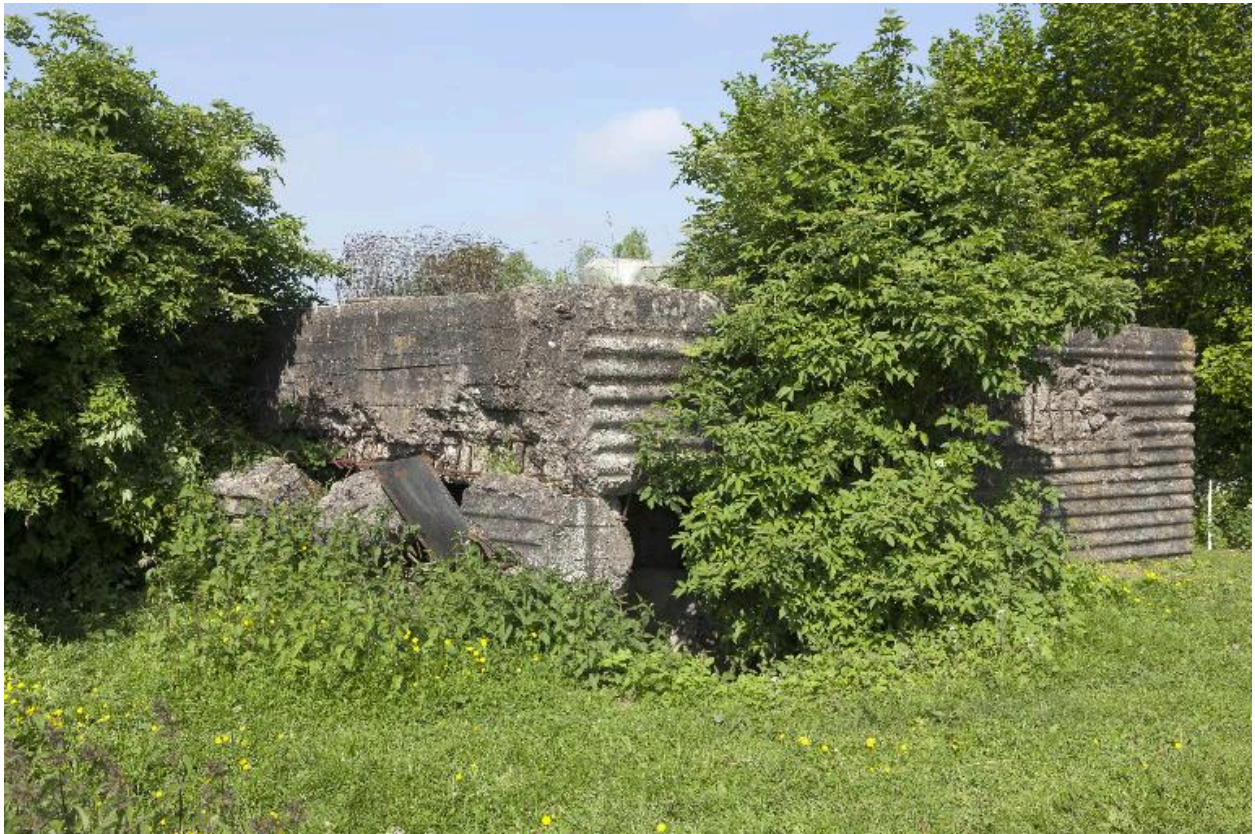
Vue de trois-quarts vers nord-ouest de la casemate dynamitée
